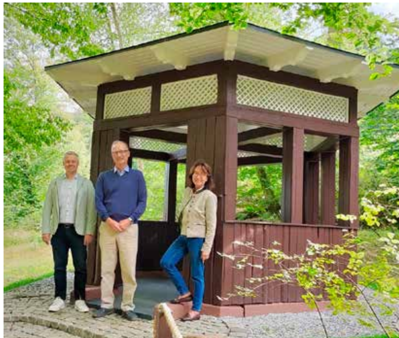
Bürgermeister Marco Eyring und Bärbel Storch, Geschäftsführerin der Staatsbad Schlangenbad GmbH, bedanken sich herzlich bei Dr. Dirk Suwelak, GuD Suwelak Stiftung und freuen sich über den sanierten Pavillon im Oberen Kurpark.
