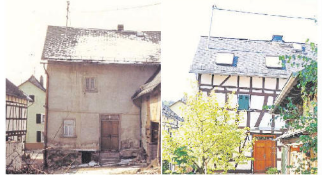
Diese erfolgreiche Sanierung eines Imerörtlichen Gehöfts in Bärstadt ist ein gutes Beispiel für die IKEK-Vorgaben.
